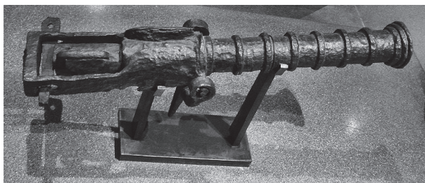
Рис. 2.39. Французская кулеврина (легкая пушка), скованная из железных полос, 1410 г.
